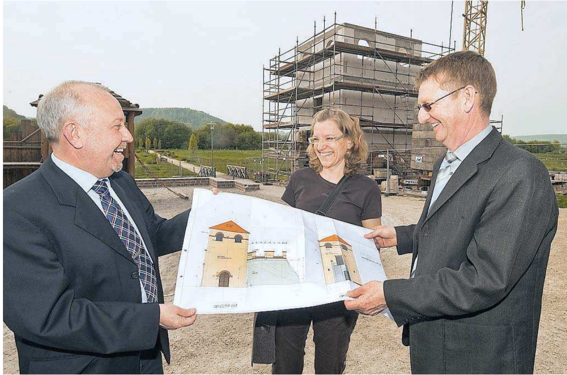
Bürgermeister Franz-Josef Berg (links) zeigt mit der Architektin Lisa Groß und dem Bauamtsleiter Felix Emanuel die Skizze für den Kastellturm, der im Hintergrund zu sehen ist. Fotos: Rolf Ruppenthal
